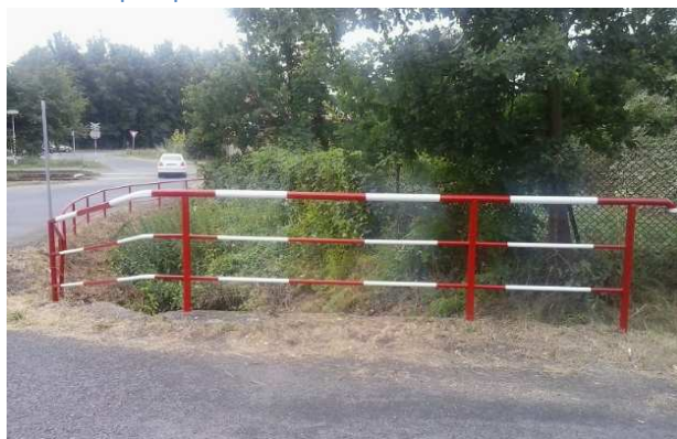
Zábradlí po opravě a novém nátěru:
