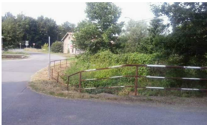
Původní stav zábradlí:
