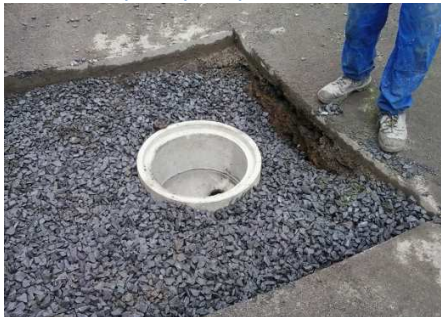
Dešťová vpuštění při opravě:
