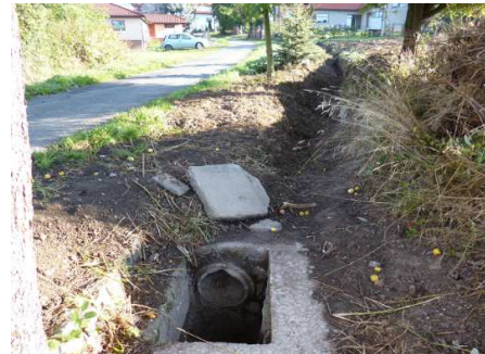
Pročištění stávajících vpustí:
